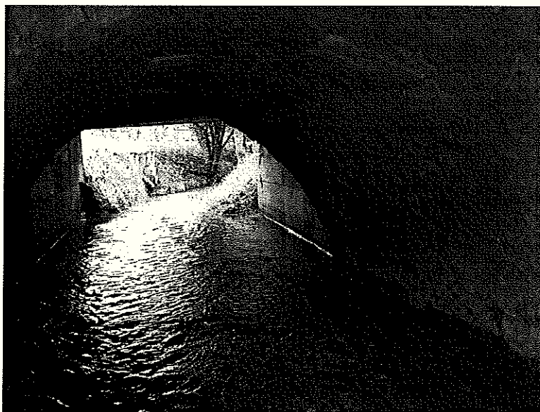
Immagine 1: Sezione in uscita al manufatto di attraversamento visto verso monte.
