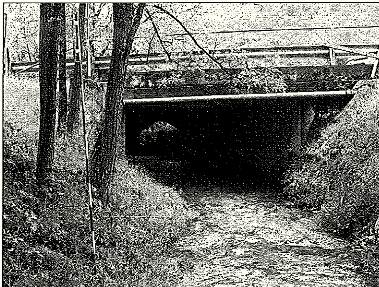
Immagine 2: Sezione di ingresso al manufatto attraversamento visto da monte.
