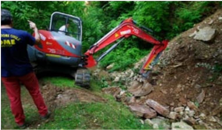
Lavori di ripristino per la frana nell'alveo del torrente Gandovere presso l'Orto Botanico
