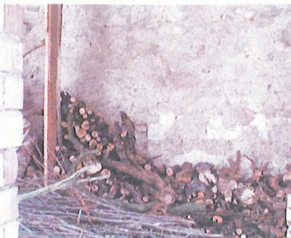
Sotto il piccolo portico si intravede sotto l'intonaco la traccia di una apertura con ghiera in cotto
