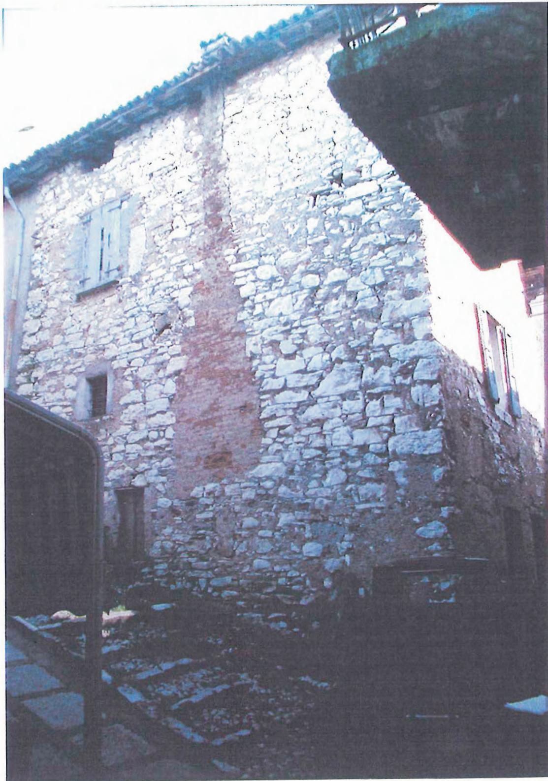
Il prospetto nord evidenzia parte della muratura originaria e stipiti di aperture
