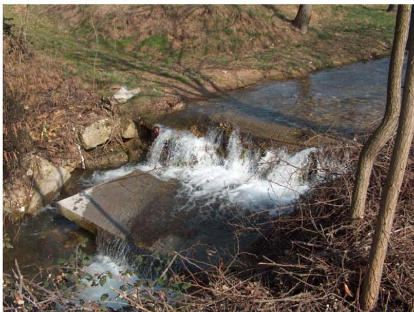
*Figura 2: Scalzamento al piede sulla platea della briglia posta a valle di un guado sul Torrente Gandovere.*
