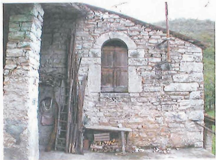
Il prospetto parziale ovest mostra una apertura a pieno centro di ottima realizzazione architettonica
