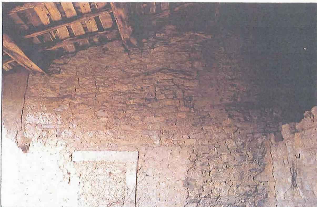
Il prospetto della torre verso la loggia, si notano le tracce delle due falde della copertura
