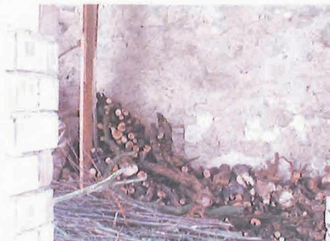
Sotto il piccolo portico si intravede sotto l'intonaco la traccia di una apertura con ghiera in cotto
